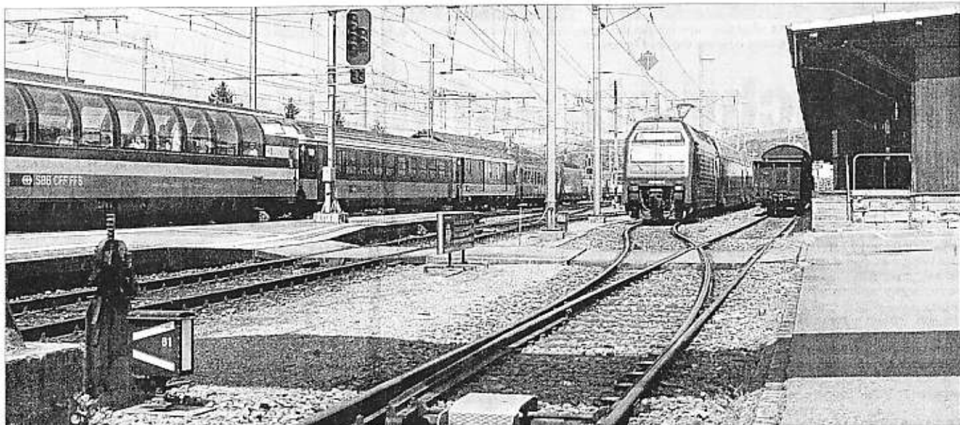
Hier stellte Gleisarbeiter Clemens Meienberg die Weichen, rechts der Güterbahnhof, der heute als Ökihof und als Brockenhaus der Frauenzentrale dient.
